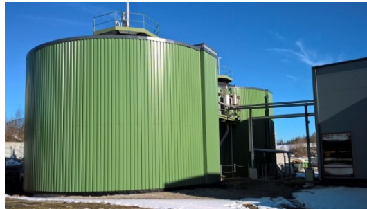
Billede 5. Reaktortanke hvor slam og pulp udrådnes i
