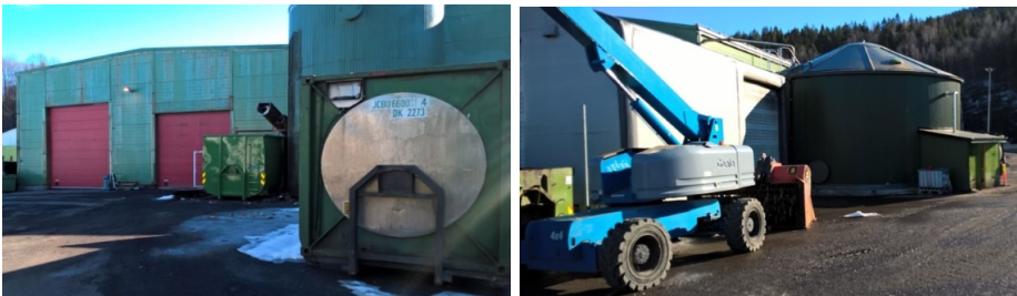
Billede 2. Bygning for håndtering af leveret organisk affald. I midten snegl for aflevering af plast fra Huber pulp maskinen.
